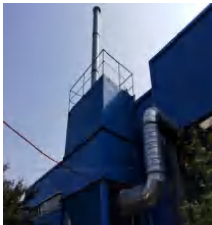
刨光废气处理设施图片
